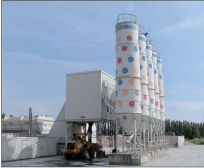
Abb. 2. Die Firma Happy Beton Stendal.
